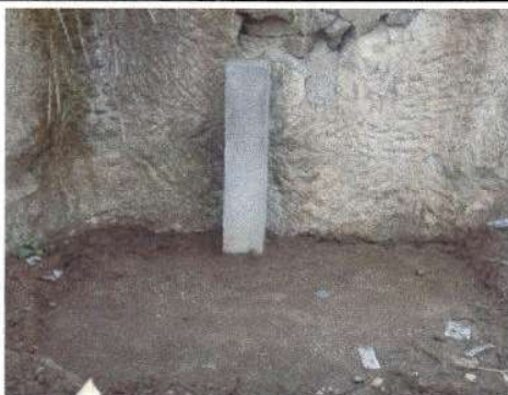
Foto 3: La calda y tapadera de aguas de sanitarios solo es de tabla, en este momento ya esta construido de puro concreto. (tapadera y su base de concreto)
