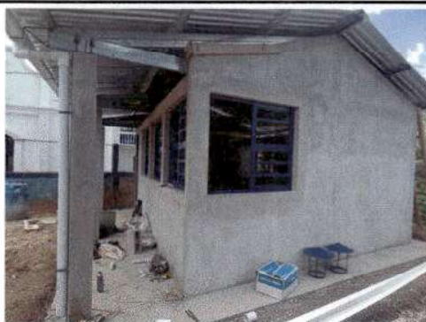
Foto 2: Esta cocina escolar solo contaba con pared. Gracias a esta ayuda se le colocó: piso, ventanas, puertas, plancha, energía eléctrica, lavadero y su techo.
